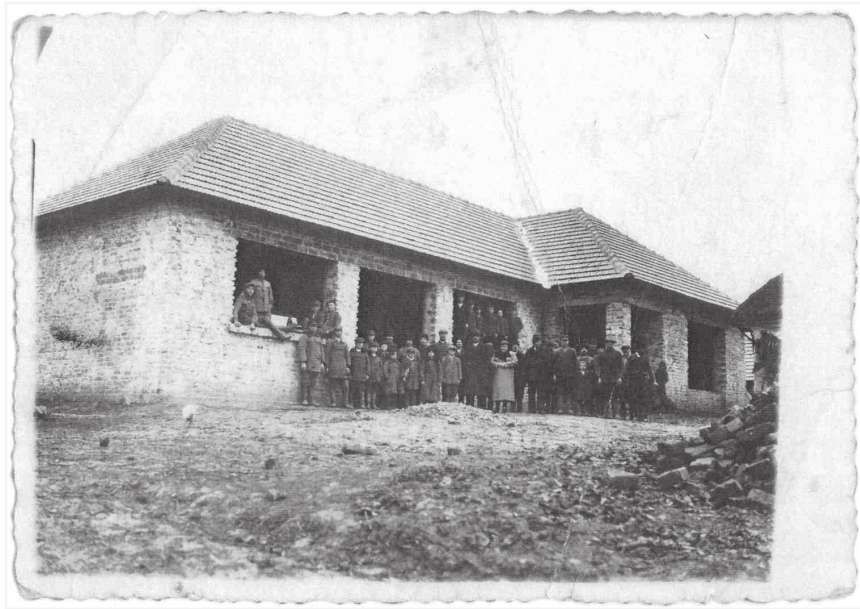
Budynek nowowypbudowanej (jeszcze niewykończonej) szkoły w Witkowcach, gm. Kłodno, pow. Krzemieniec, woj. wołyńskie. Z archiwum rodzinnego Małgorzaty Krasinkiewicz z Sokołowic-Oleśnicy
